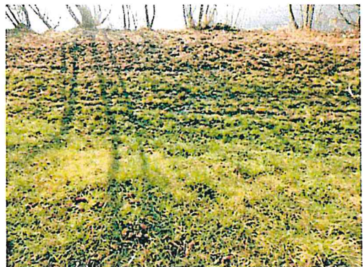
Výron vody na vzdušném svahu pod nátrží na návodní straně
