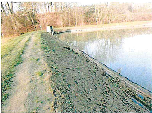
Pohled na hráz a výpustný objekt Nátrže v místech průsaku
