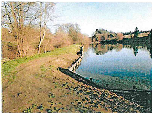
Opevnění a poškozený návodní svah boční hráže
